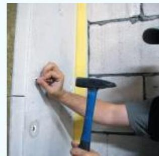
**ВНИМАНИЕ! Головка винта утапливается в поверхность виброузла не более чем на 1-2 мм!**
