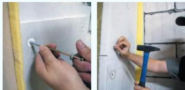
**ВНИМАНИЕ! Головка винта утапливается в поверхность виброузла не более чем на 1-2 мм!**
